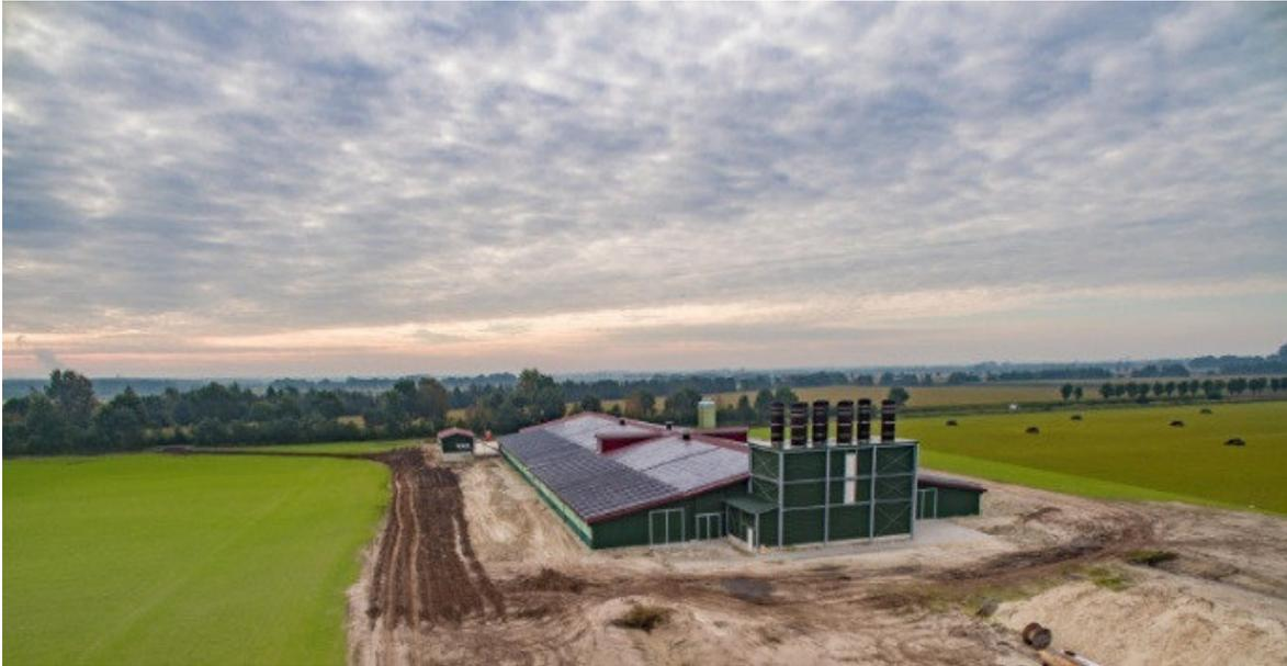
**Bild 3:** Beispiel für eine Stallanlage mit angeschlossener Abluftreinigungsanlage: das gereinigte Abgas wird aus Abluftkaminen, die senkrecht über der Abluftreinigungsanlage angeordnet sind, in die Atmosphäre freigesetzt (Quelle: Inno+)
